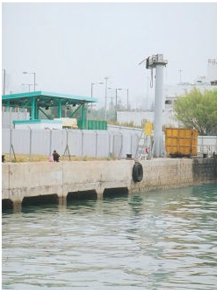
油麻地海上垃圾收集站的垃圾斗和轉柱挺桿起重機
