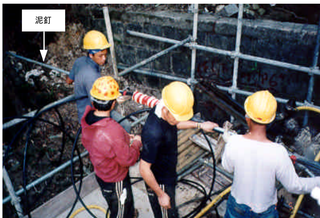
泥釘安裝工程示例
