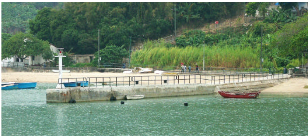
沒有鋼筋混凝土構件的民政事務總署實心碼頭 (大嶼山 稔樹灣)
