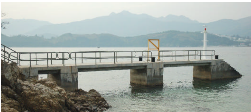
有鋼筋混凝土構件的民政事務總署碼頭 (西貢 橋咀)
