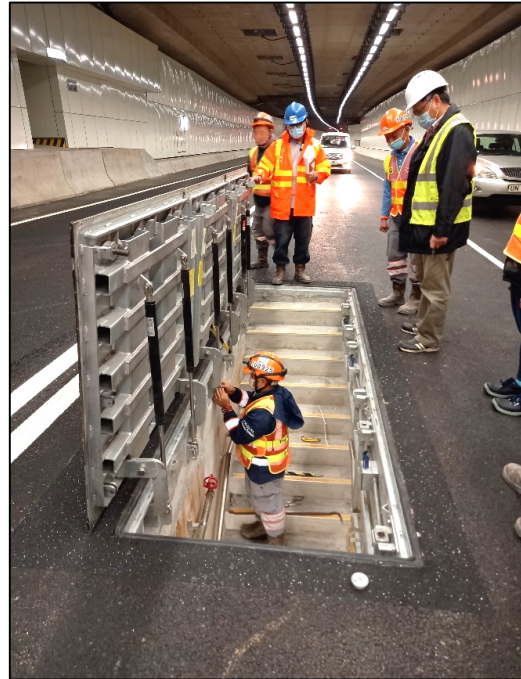
屯門-赤鱸角隧道沿車道設置的緊急通道艙口
