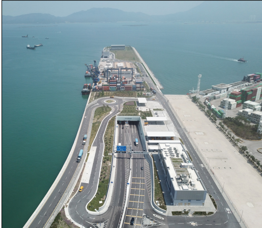
在合約B下建造的屯門-赤鱸角隧道北面出入口 (2021年4月)
