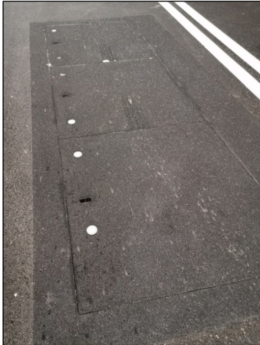
屯門-赤鱸角隧道沿車道設置的緊急通道艙口
